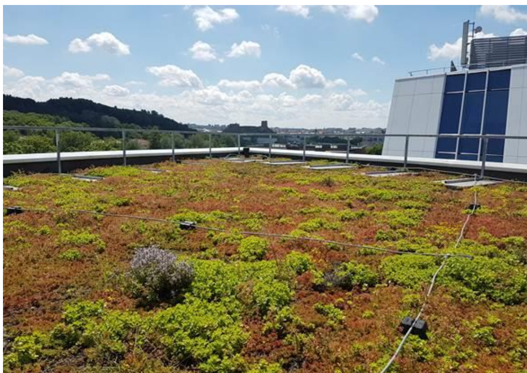
Obrázek 13 Extenzivní vegetační střecha
