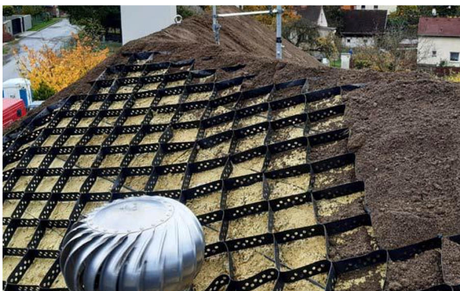
Obrázek 17 Stabilizace vegetačního souvrství geobuňkami
