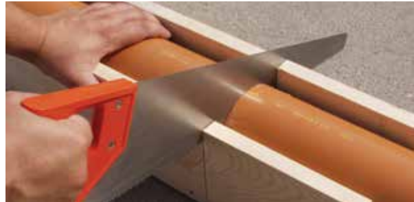
Obrázek 2 Zkracování trubky pilkou
