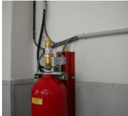
detail spouštěcího ventilu
