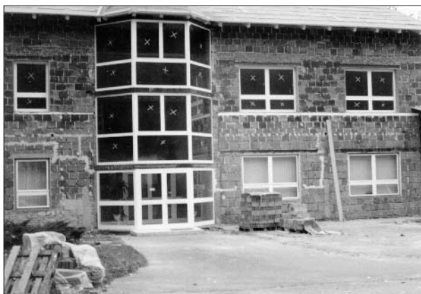
Obr. 1.4. Stavba vlastních výrobních a administrativních prostor
