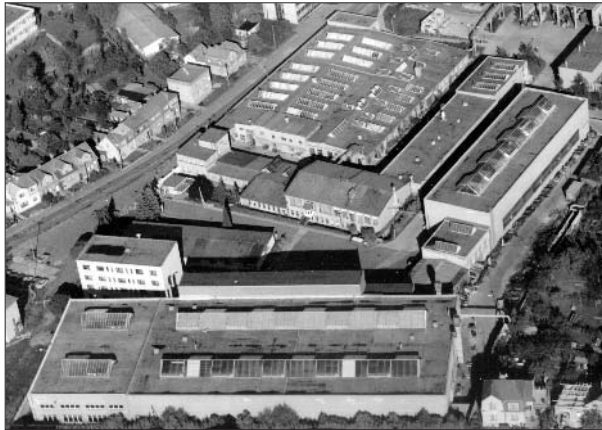
Obr. 1.6. Výrobní areál LDM, dnešní sídlo firmy
