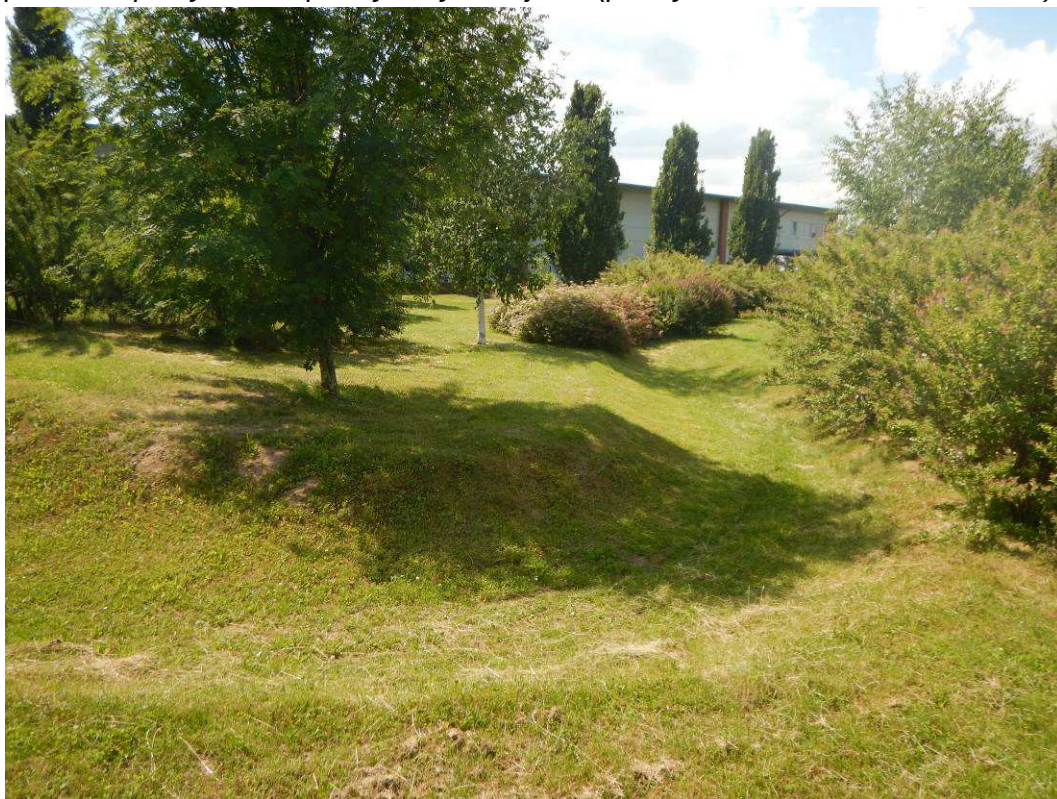
Obr. 15: Vsakovací průleh, který navazuje na retenční nádrž a který je vhodně zapojen do parkové úpravy v okolí průmyslových objektů (průmyslová zóna Praha - Čestlice).
