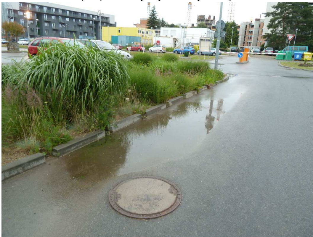
Obr. 13: Využití plošného vsakování srážkových vod vytvořením menších plošek, kterými jsou rozděleny souvislé zpevněné plochy s využitím odvodnění mezerami mezi obrubníky (kampus Masarykovy univerzity v Brně).
