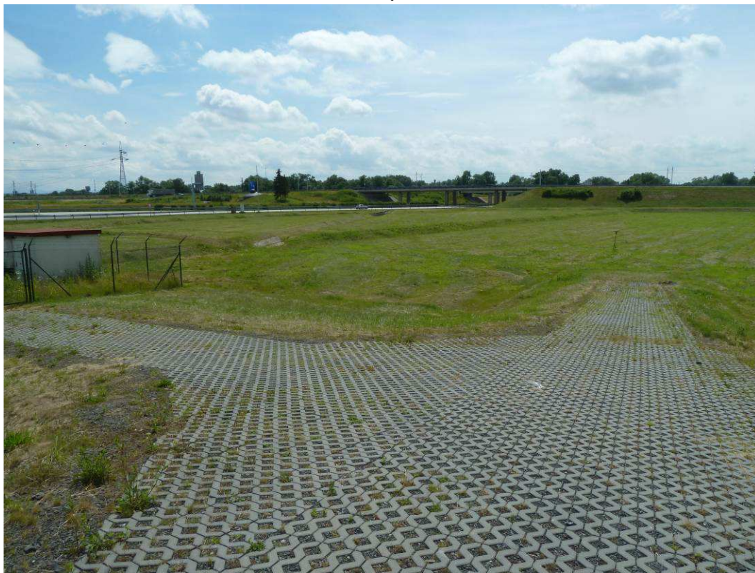
Obr. 16: Rozsáhlá vsakovací nádrž a vsakování přes polovegetační tvárnice (dálnice D1, exit 370).
