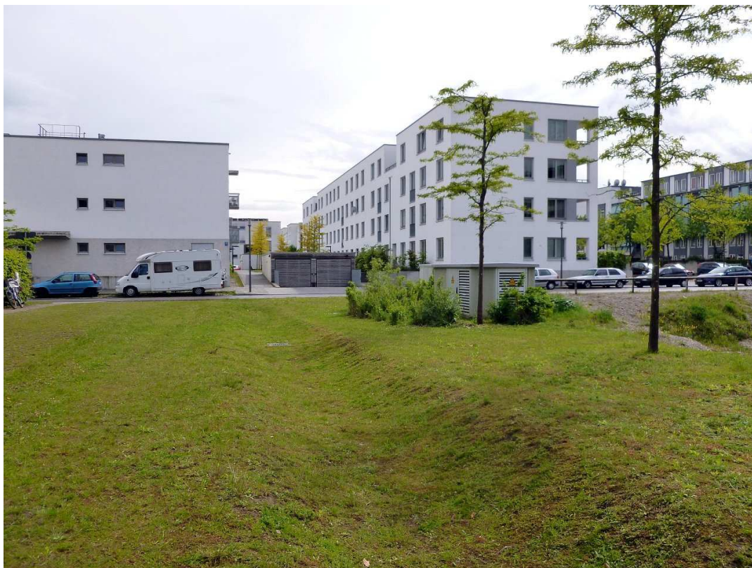
Obr. 5: Vsakovací průleh (Německo, Mnichov-Riem)
