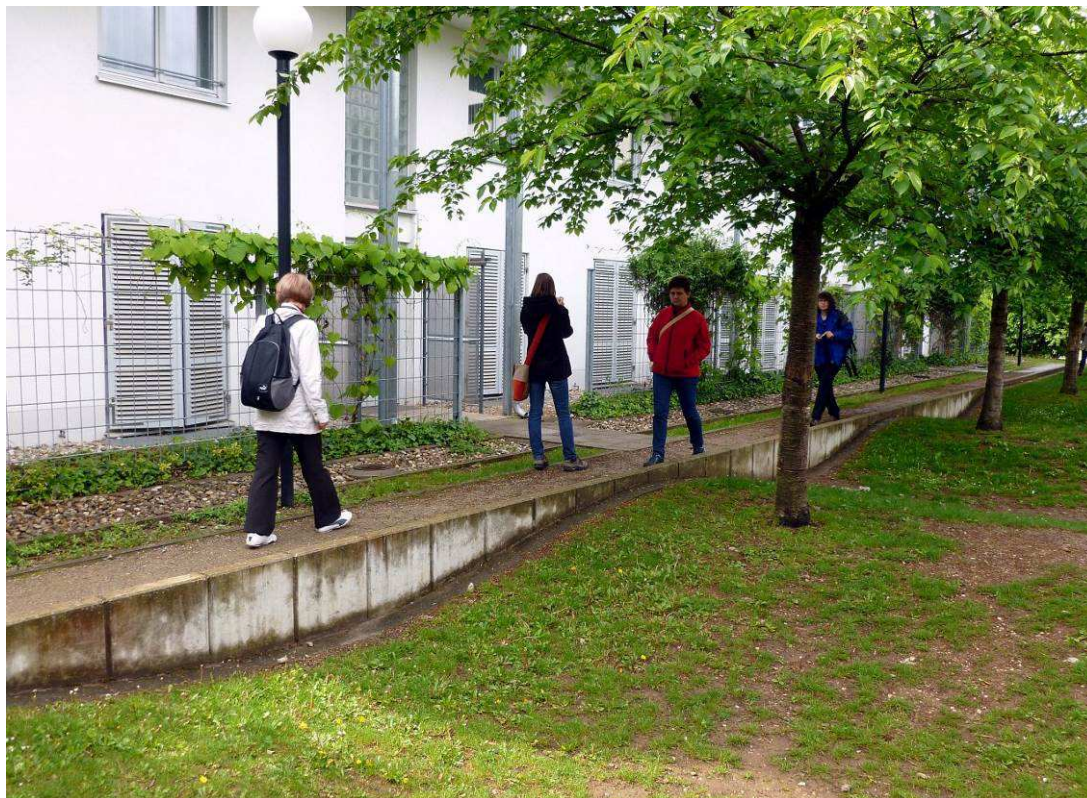
Obr. 4: Zdařilé architektonické začlenění vsakování v průlezích ve vnitrobloku (Německo, Mnichov-Riem)
