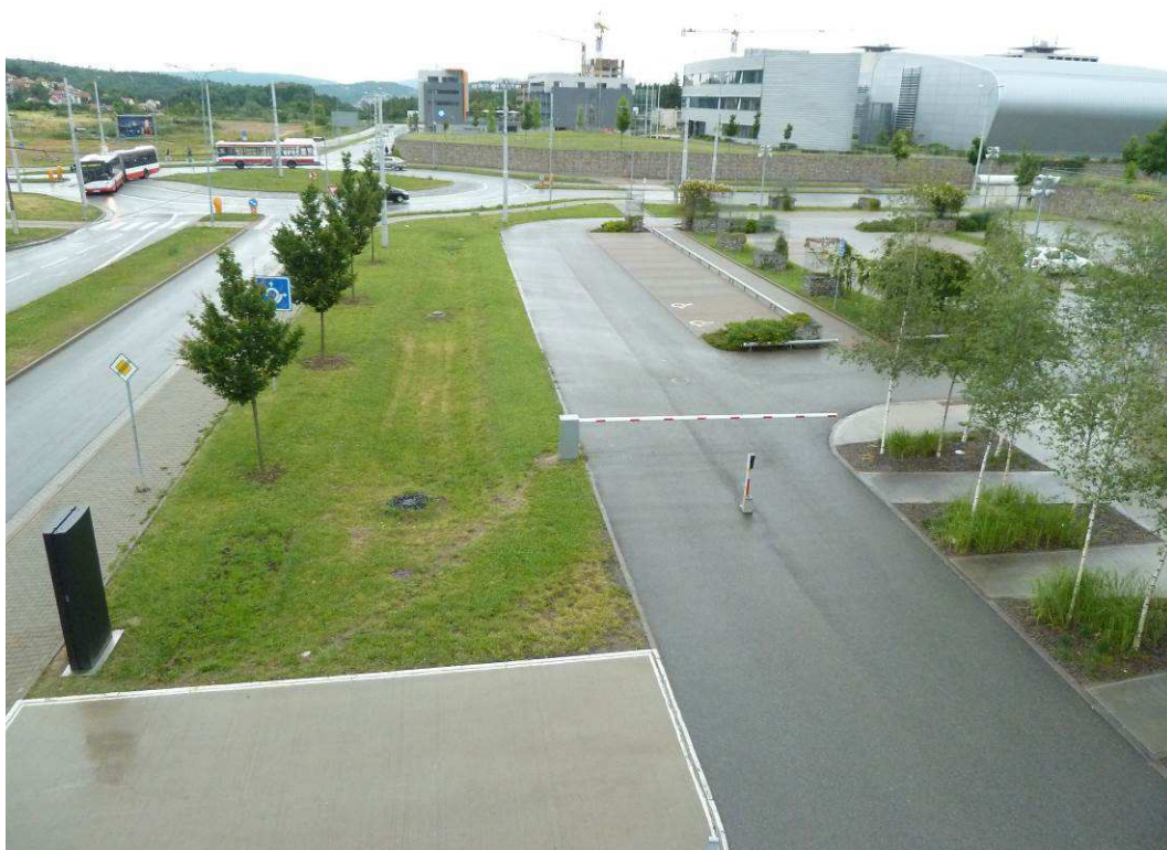
Obr. 18: Vsakovací průleh – rýha, využití zelené plochy mezi silničními pruhy městské dopravní sítě (Brno, ulice Netroufalky).
