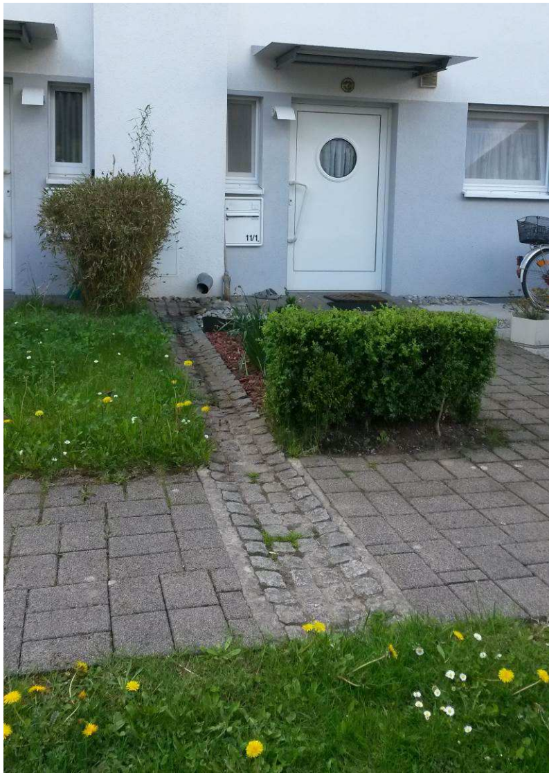
Obr. 1: Zaústění vod z okapu ke vsakování na trávníku (Německo, Ostfildern)
