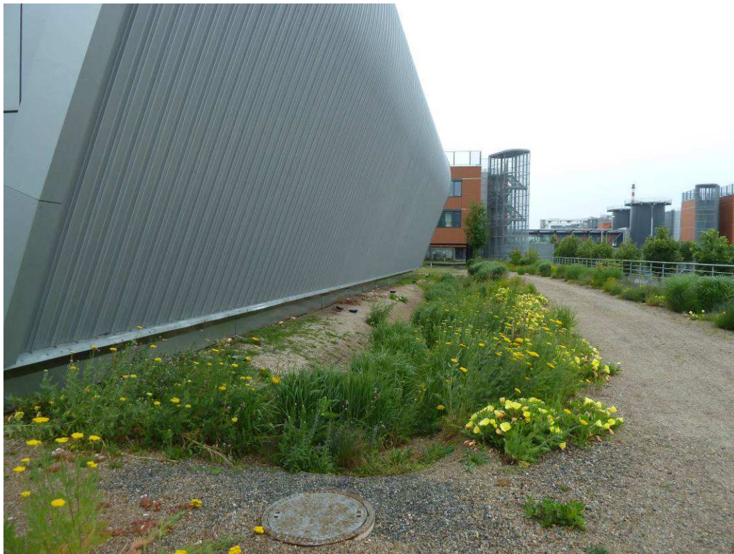
Obr. 17: Vsakovací průleh – rýha, do kterého stékají dešťové srážky z rozsáhlé střechy a který zároveň vytváří zajímavý záhon s okrasnými rostlinami (kampus Masarykovy univerzity v Brně).
