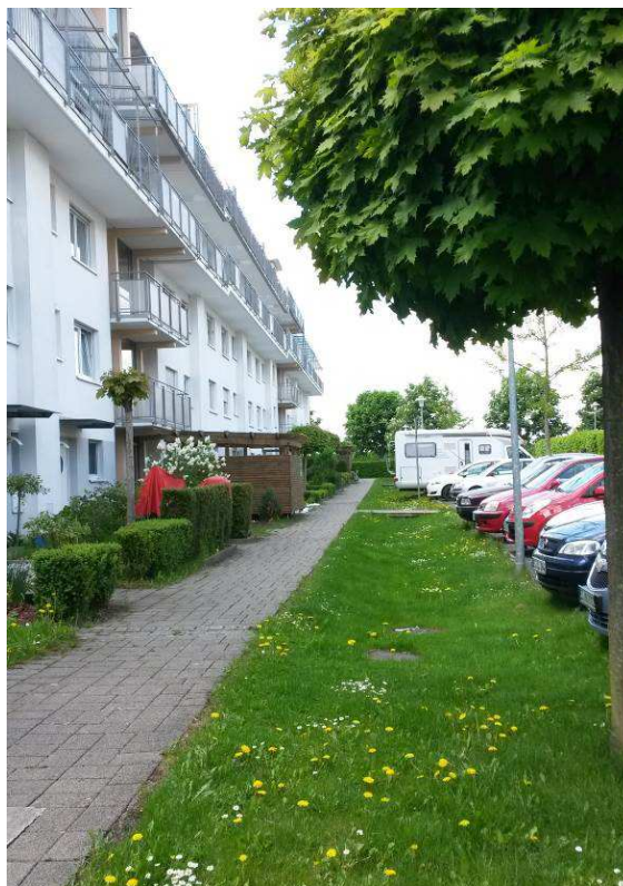
Obr. 3: Chodník s příčným sklonem umožňujícím odvodnění směrem do mělkých prohlubní v trávniku a ke stromům (Německo, Ostfildern)
