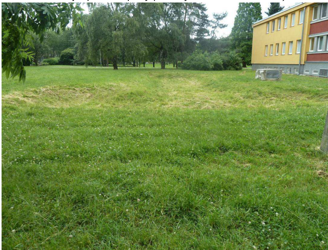
Obr. 19: Vsakovací průleh – rýha v centrální části města, opatření vhodně zapojené do navazující parkové úpravy (Městský kulturní dům v Karviné).
