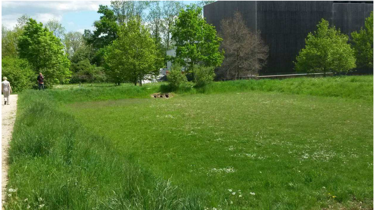
Obr. 7: Vsakovací zařízení kombinované s biotopem (Švýcarsko, Oberegg)
