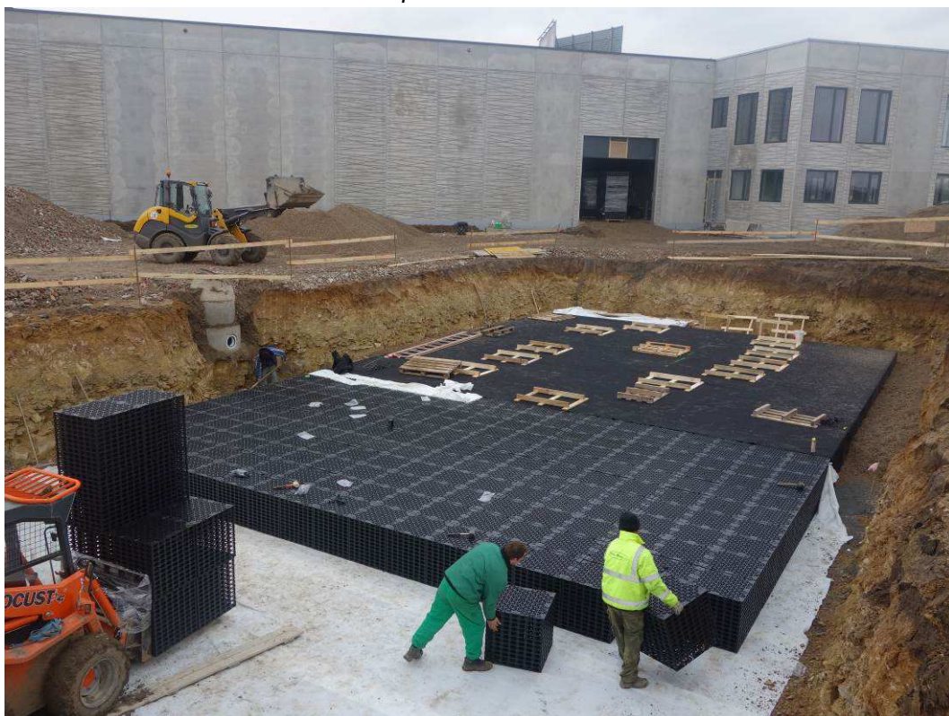
Obr. 21: Odvodnění pomocí systému vsakovacích bloků – pokládka na urovnaný terén a podkladní lože.
