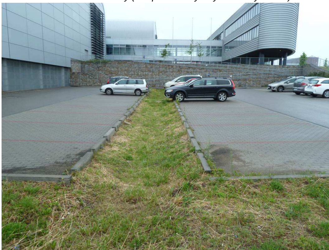
Obr. 14: Vsakovací průleh v kombinaci s řešením odvodnění zpevněné plochy pomocí mezer mezi obrubníky (kampus Masarykovy univerzity v Brně).
